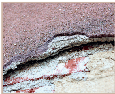
↑ Obr. 20: Soběslav, Dolní Příkopy, dům čp. 80, detail vícevrstvé břizolitové omítky s hrubozrnnou strukturou, měkkým jádrem a finální probarvenou vrstvou tvrdé omítky.
