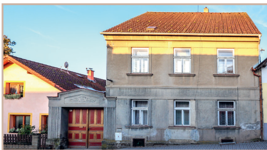
↑ Obr. 63: Želeč u Tábora, venkovský dům čp. 134, 1927, příklad fasády z tvrdé cementové omítky s příměsí slídových částic. Foto: David Peltán, 2024
