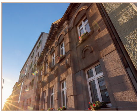
↑ Obr. 19: Tábor, Budějovická ulice, bytový dům čp. 1222/15, 1922-1923, příklad rondokubistického domu s fasádou z tvrdé omítky. Foto: David Peltán, 2024
