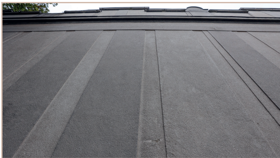
↑ Obr. 51: Vodňany, Husův sbor, 1923–1925, břizolitová omítka se zrny slídy. Foto: David Peltán, 2024
