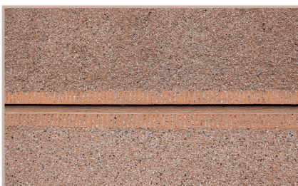
↑ Obr. 27: Písek, Harantova ulice, dům čp. 1542/29, detail povrchu vymývané omítky se šanýrem. Foto: David Peltán, 2024
