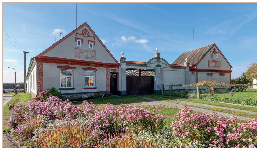
↑ Obr. 58: Záluží u Vlastiboře, venkovská usedlost čp. 12, úprava pojetí fasády průčelí z roku 1928.
