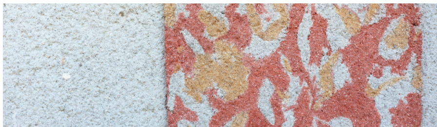
↑ Obr. 61: Záluží u Vlastiboře, venkovská usedlost čp. 12, detail barevného mramorování v břizolitové omítce. Foto: David Peltán, 2024
