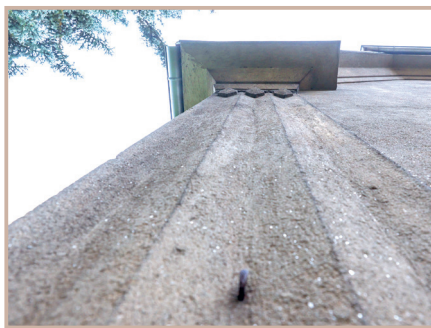
↑ Obr. 21: Týn nad Vltavou, kostel Evangelické církve metodistické, detail jemnozrnné břizolitové omítky z dvacátých let 20. století, viditelná jsou lesklá zrna slídy.
