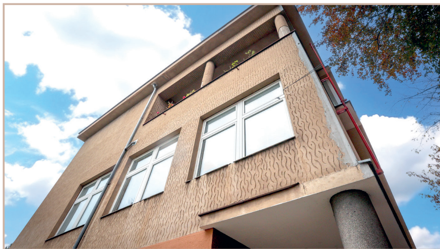
↑ Obr. 55: Týn nad Vltavou, Základní škola Týn nad Vltavou, Malá Strana (dříve Základní devítiletá škola), pohled na stěnu s rýhovanou omítkou. Foto: David Peltán, 2024
