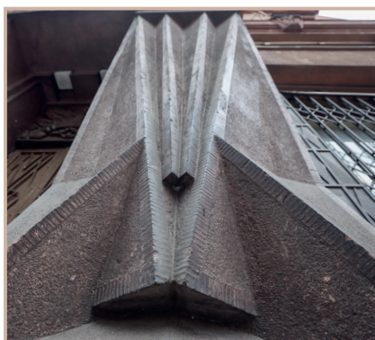
↑ Obr. 39: Praha, odborový dům Na Perštýně, 1920–1922, Alois Dryák, výrazný architektonický prvek průčelí – lomený pilastr s typickými ostrými hranami a geometrickým členěním. Foto: David Peltán, 2024
