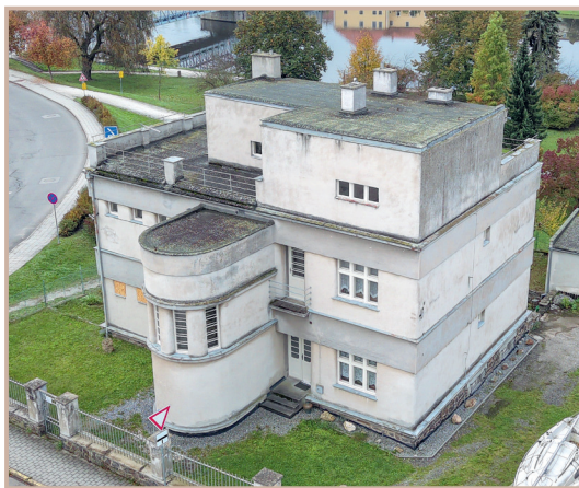
↑ Obr. 52: Týn nad Vltavou, Bargerova vila, Adolf Beneš, příklad kvalitní puristické stavby. Foto: David Peltán, 2024
