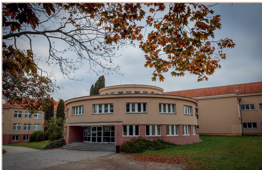
↑ Obr. 54: Týn nad Vltavou, Základní škola Týn nad Vltavou, Malá Strana (dříve Základní devítiletá škola). Foto: David Peltán, 2024
