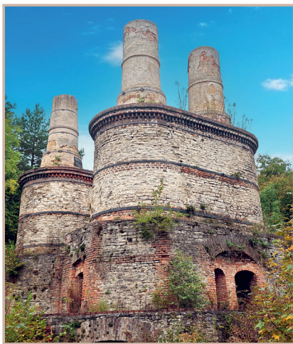
↑ Obr. 16: Praha-Velká Chuchle, bývalá Pacoldova vápenka. Foto: Petr Kotrba, 2025
